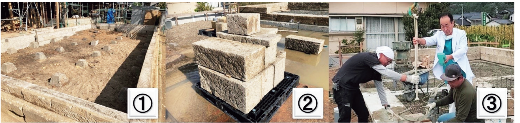
写真4 ①は旧一ノ蔵でこのように石が組み立てられた。②は解体された蔵の石で基礎石である滝原石「たきがはらいし」と言い、一つの大きさは60cmx60cmx100cm。③は一番石の組上げを当主が行っているところ
