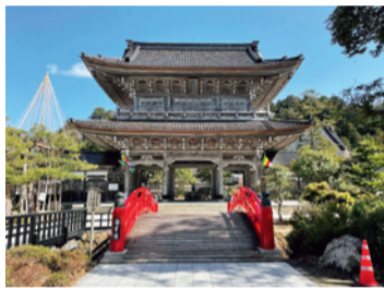
写真1 修復された山門
