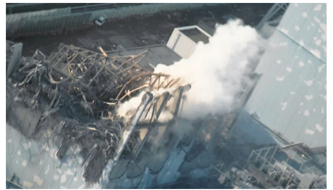
水素爆発をした2日後に白煙を上げる3号機=2011年3月16日（写真：東京電力ホールディングス）
