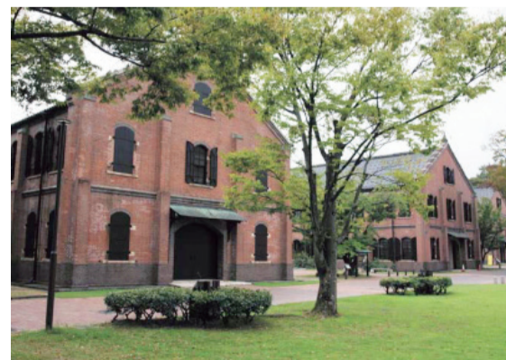
石川県立歴史博物館 明治末期～大正初期に建造され、第九師団の弾薬を除く物資の倉庫として利用された。戦後は金沢美術工芸大学に転用され、1986（昭和61）年以降は県立歴史博物館として活用されている。
